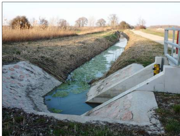
6. kép – Az oldalcsatorna felújított medre
